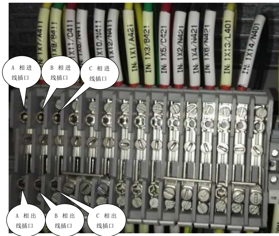
图 6.3 三相三线电流接线方式
