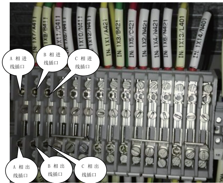
图6.3三相三线电流接线方式
